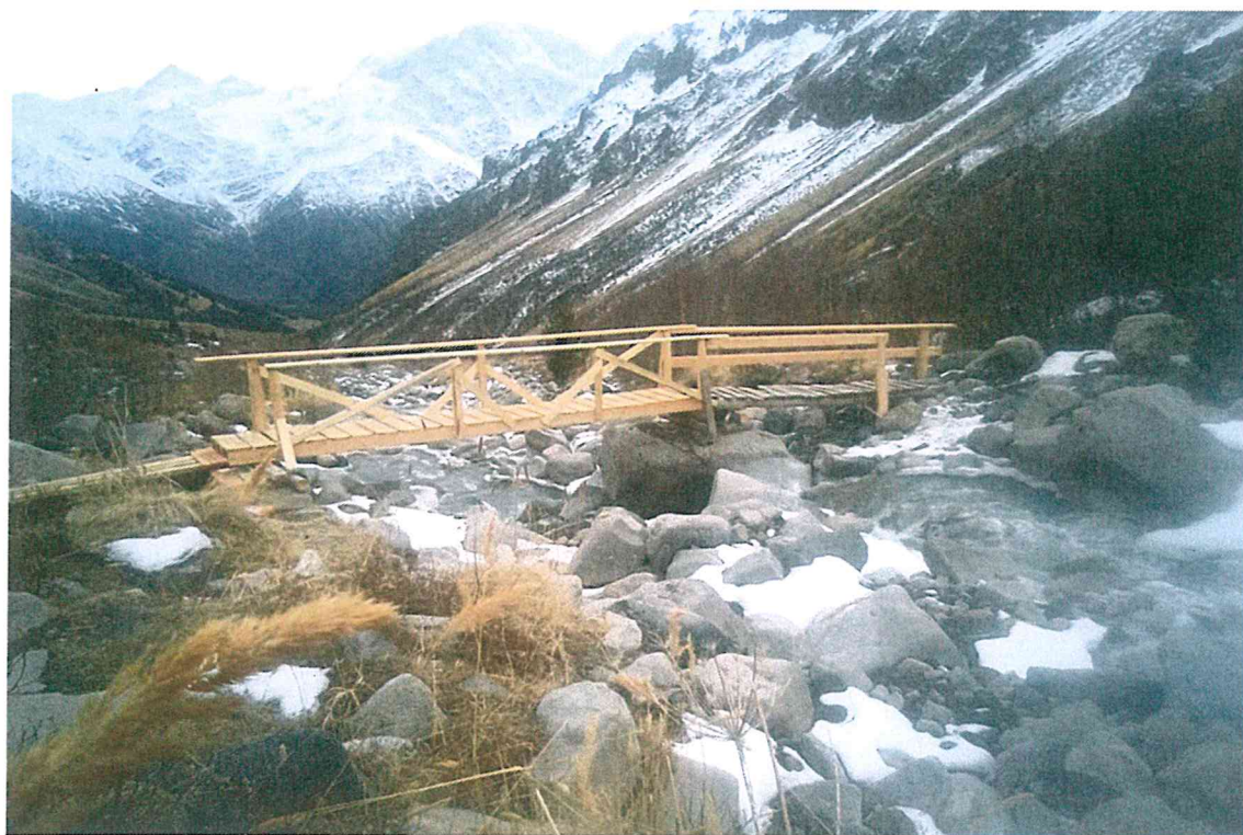
2. Пешеходный мост через р. Терскол
